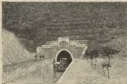
Fig. 2. Entrada del túnel principal en el canal de Kioto-Fu, en el Japón
